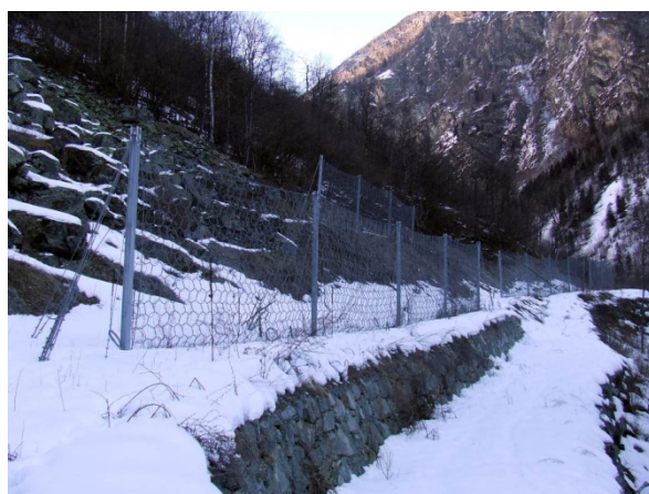
Immagine relativa al vallo rilevato (a destra) e delle reti paramassi (a sinistra)
