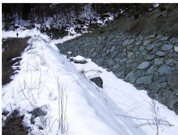
Immagine relativa al vallo rilevato (a destra) e delle reti paramassi (a sinistra)
